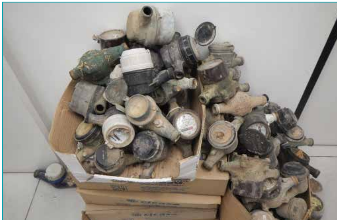
Figura 6.1. Medidores sustituidos por deterioro.
