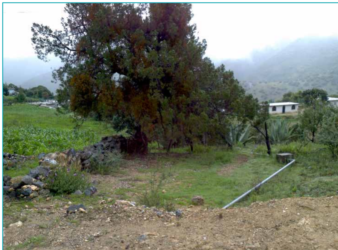
Figura 9.1. Infraestructura y servicio de agua potable de la CEA Querétaro, en comunidades rurales dispersas del municipio de Cadereyta, Querétaro.
