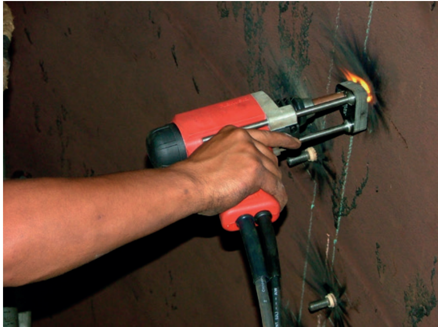
Figura 2.32 Colocación de pernos autosoldables.
