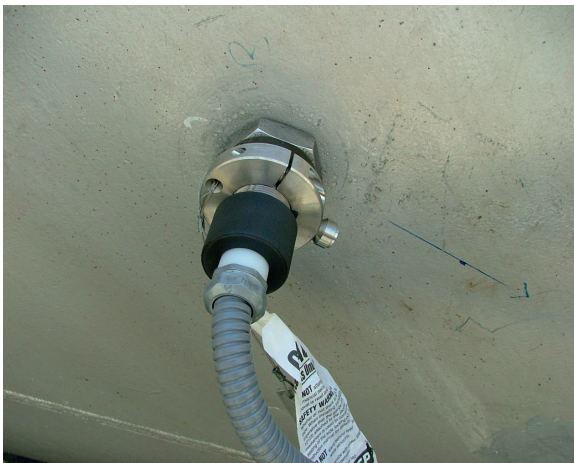
Figura 3.47 Vista de los sensores de inserción.
