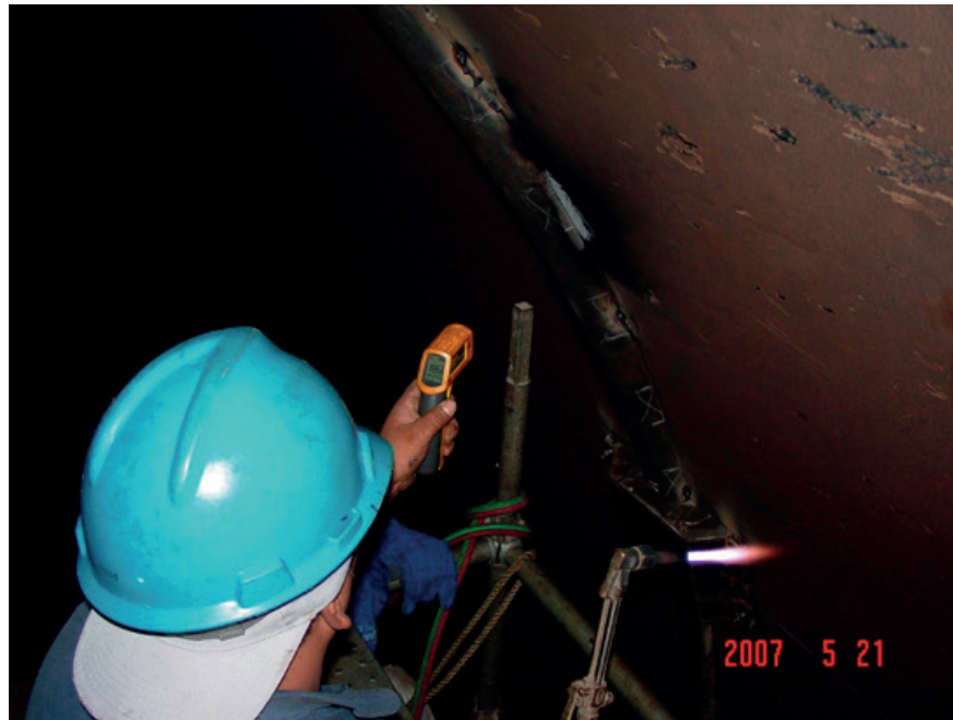
Figura 2.28 Medición de temperatura adecuada de precalentamiento.
