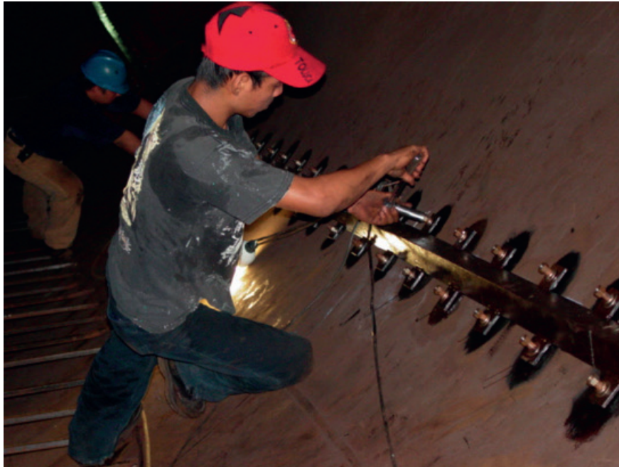
Figura 2.34 Elemento de sujeción fijado con pernos autosoldables.
