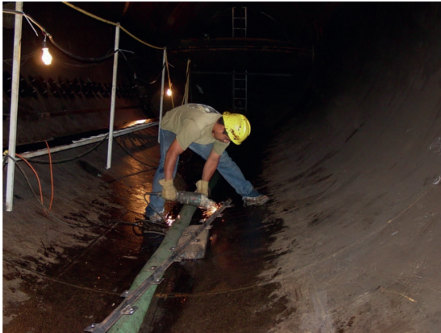
Figura 2.27 Precalentamiento previo a la aplicación de material de aporte para soldar elementos.
