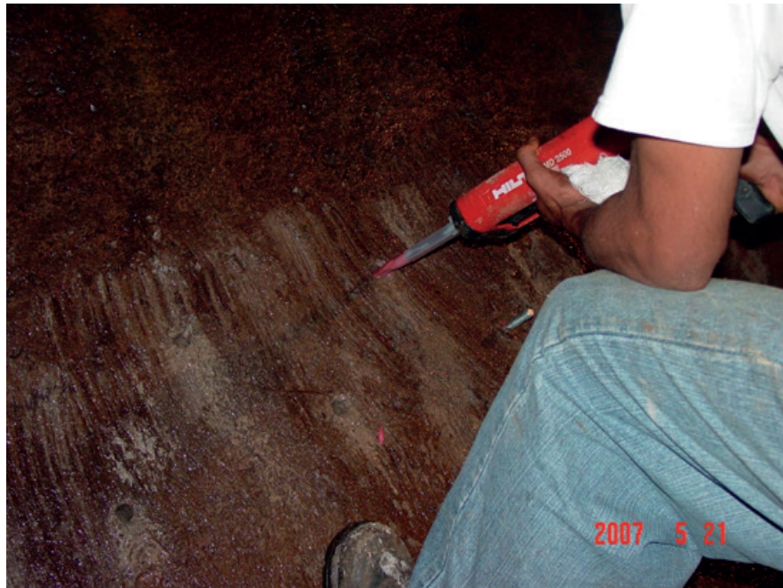
Figura 2.36 Aplicación de anclaje químico para fijar pernos.
