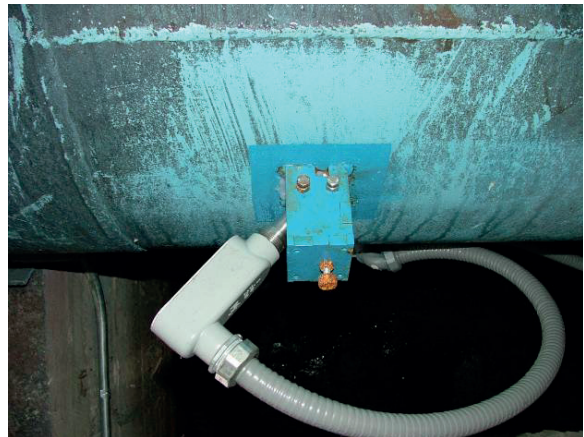
Figura 3.26 Vista del sensor con su placa soldada.
