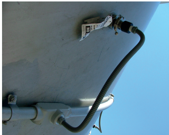
Figura 3.47 Vista de los sensores de inserción.
