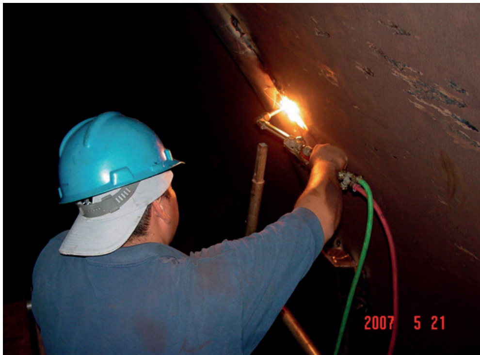
Figura 2.27 Precalentamiento previo a la aplicación de material de aporte para soldar elementos.
