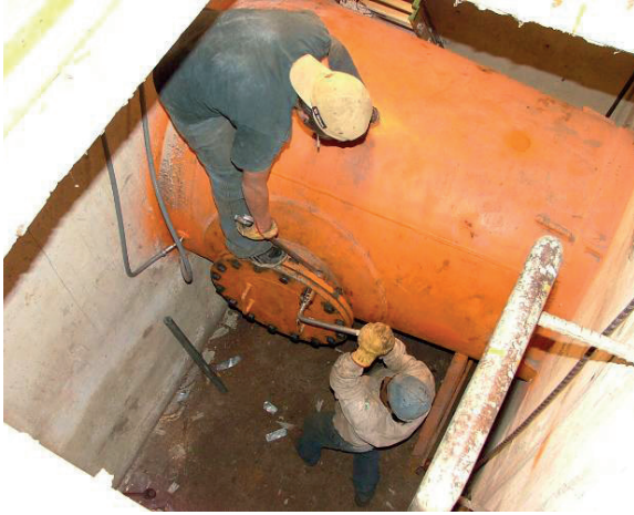
Figura 3.41 Colocación de la escotilla.
