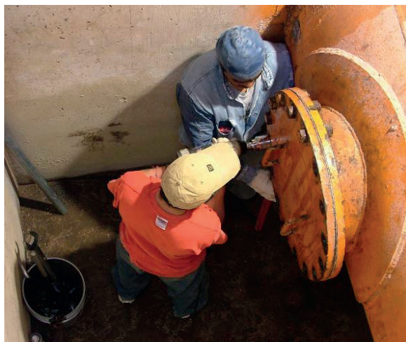
Figura 3.31 Perforación de la tubería para la salida de los cables de sensores.
