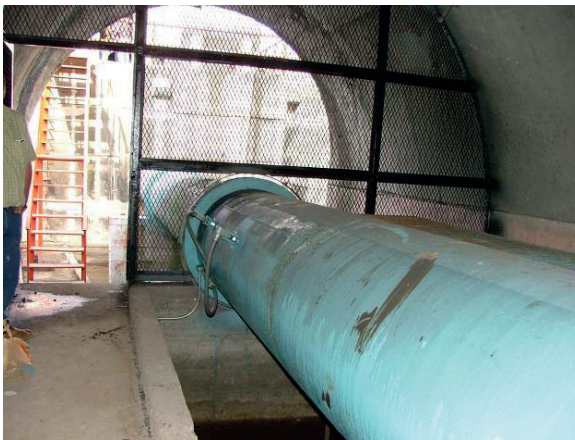
Figura 3.27 Vista hacia aguas abajo.
