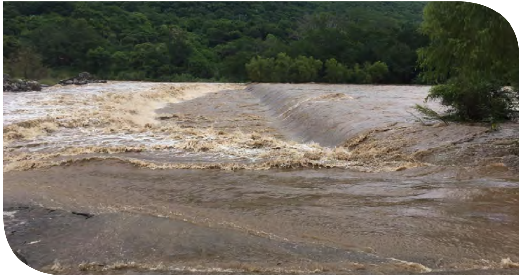
Figura 7.7. Presa derivadora en el río Armería, DR053 Estado de Colima. Foto: Ernesto Sánchez Parbul.
