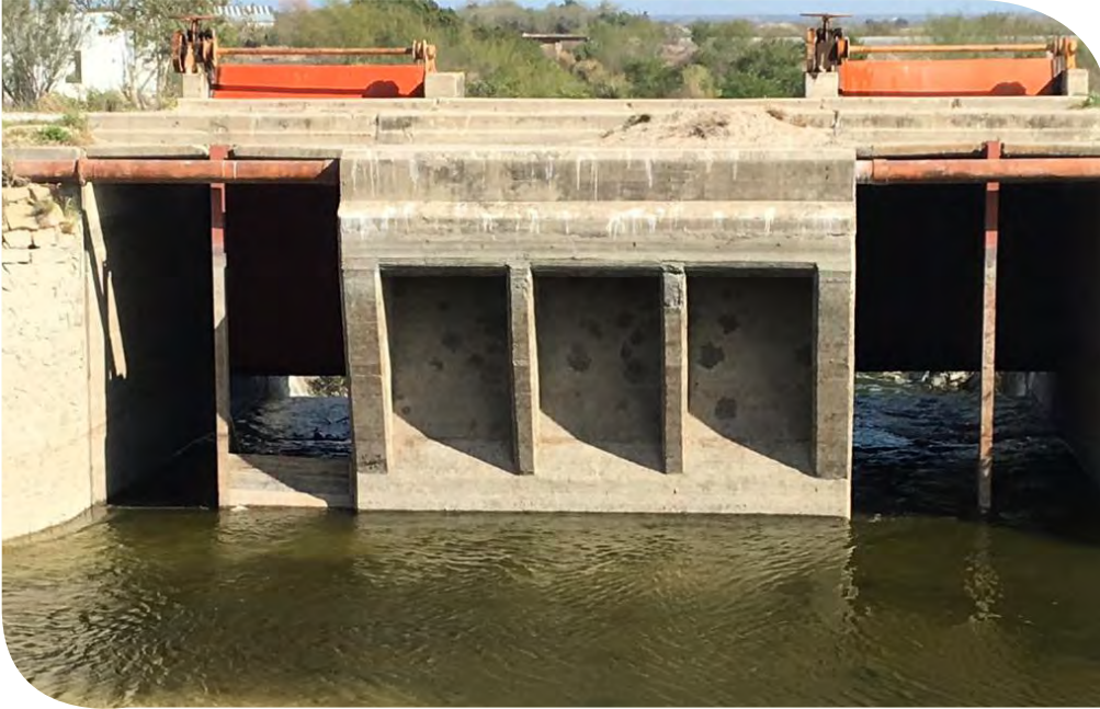
Figura 7.42. Desagüe parcial. Km 21+400 Canal Rode DR026 Bajo Río San Juan, Tam. Fotografía: Armando Silva.
