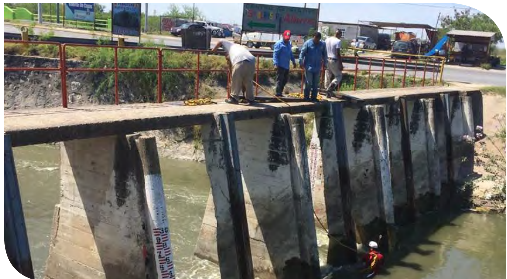
Figura 7.16. Represa con agujas de madera.
