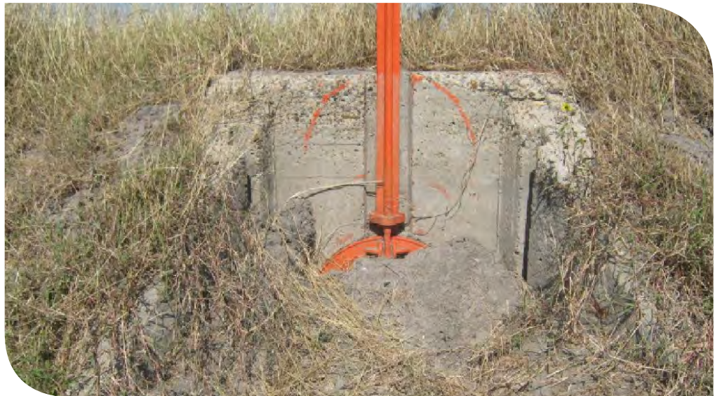
Figura 7.28. Toma-granja tipo Miller azolvada intencionalmente.
