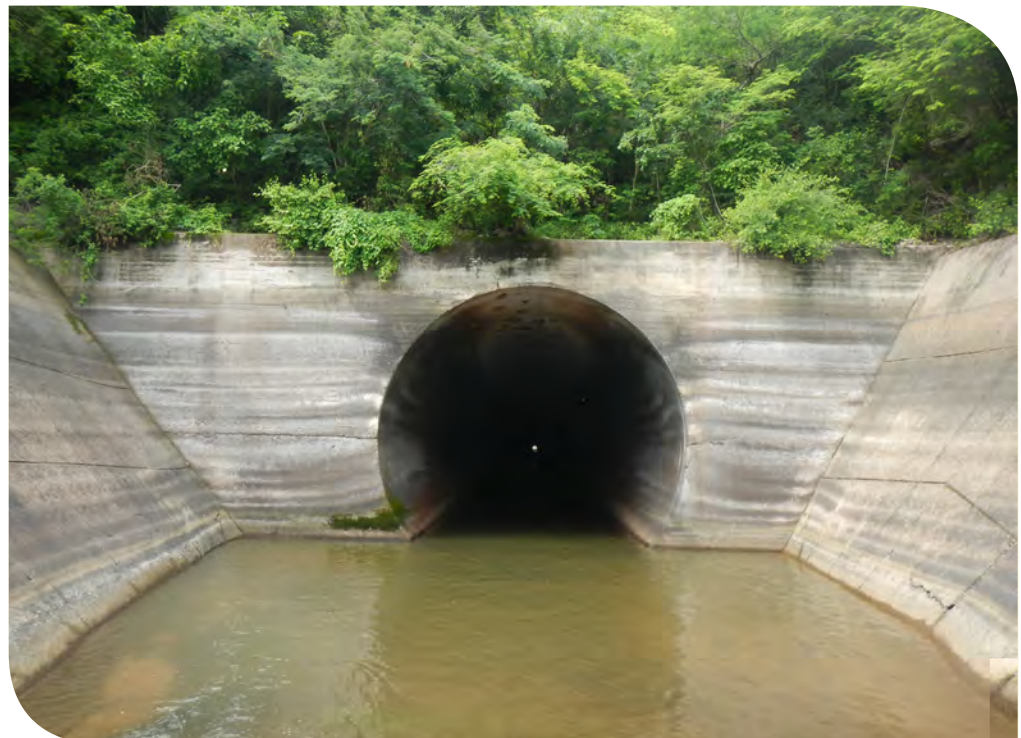
Figura 7.38. Salida del túnel El Tecorito. Fotografía: Eduardo Chan Gaxiola.
