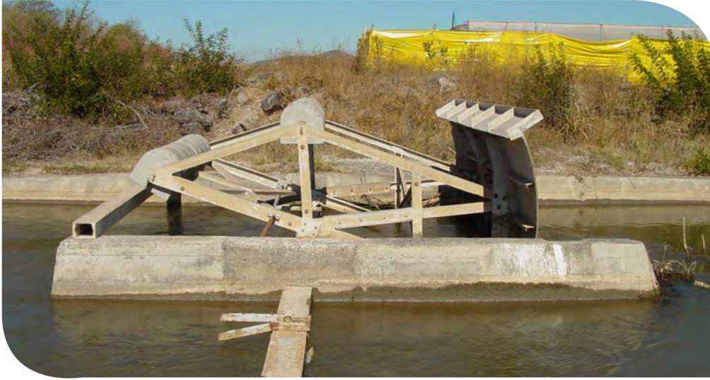
Figura 7.18. Compuerta AMIL de fibra de vidrio. DR053 Estado de Colima, Colima. Fotografía: Ariosto Aguilar Chávez.
