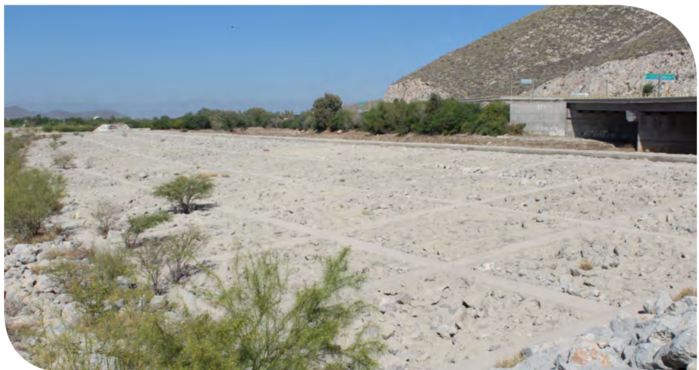
Figura 7.8. Presa derivadora sobre el río Nazas. Fotografía: Cynthia Larisa Nava Salto.
