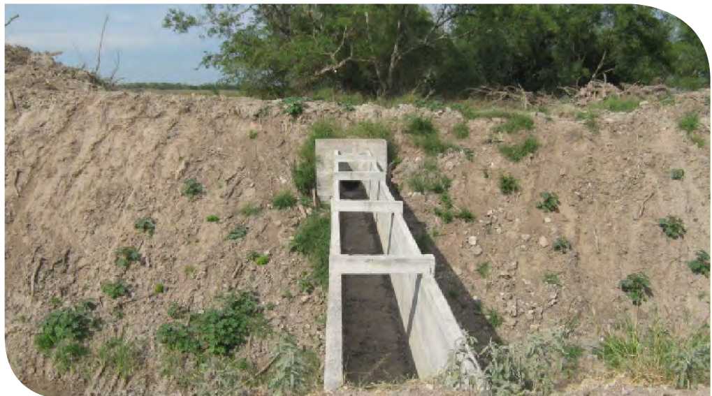
Figura 7.36. Puente canal en el Módulo de Riego II-2, DR025 Bajo Río Bravo, Tamps.
