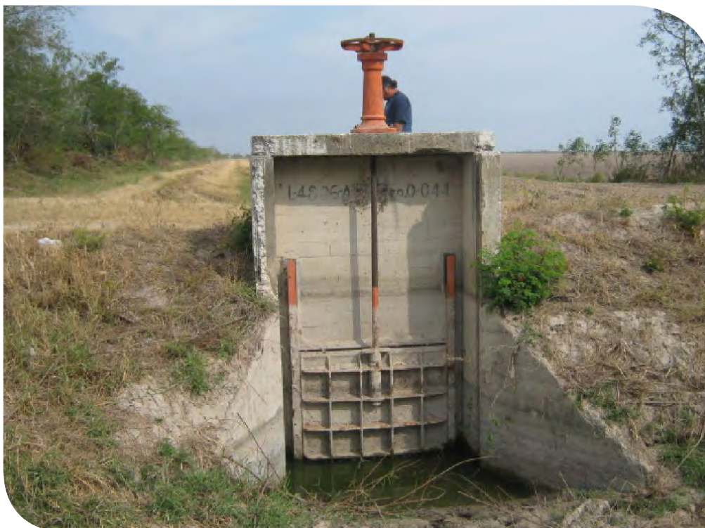
Figura 7.26. Compuerta plana rectangular.
