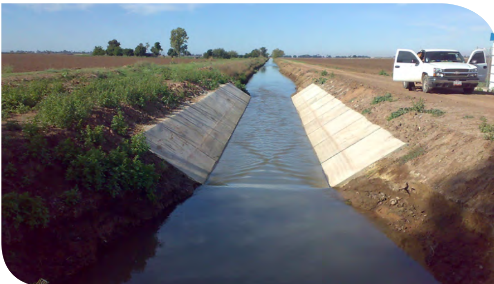
Figura 7.12. Canal de tierra con una sección revestida para fines de hidrometría ultrasónica. DR041 Río Yaqui, Son.
