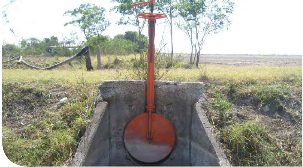
Figura 7.27. Compuerta tipo Miller. DR025 Bajo Río Bravo, Tamps.
