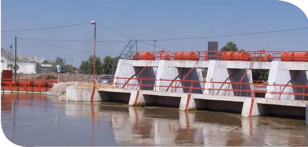
Figura 7.9. Compuertas de entrada a los canales Santa Rosa Tlahualilo (izquierda) y Sacramento (derecha).
