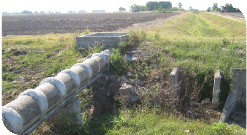
Figura 7.35. Puente canal en el módulo III-4, DR025 Bajo Río Bravo, Tamps.
