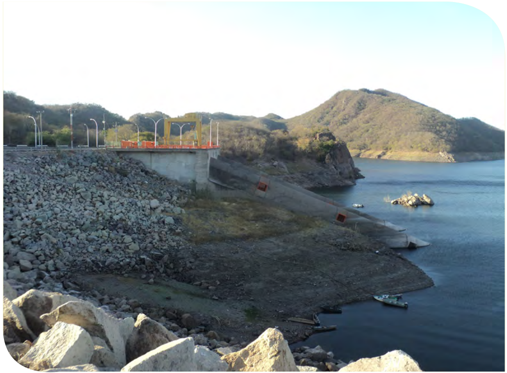
Figura 2.2. Presa de almacenamiento DR010 Culiacán, Sinaloa.
