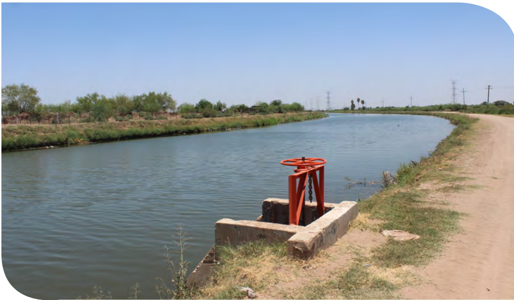
Figura 7.11. Canal Bajo del Yaqui, construido en tierra. Fotografía: Ernesto Garcés Rivas.
