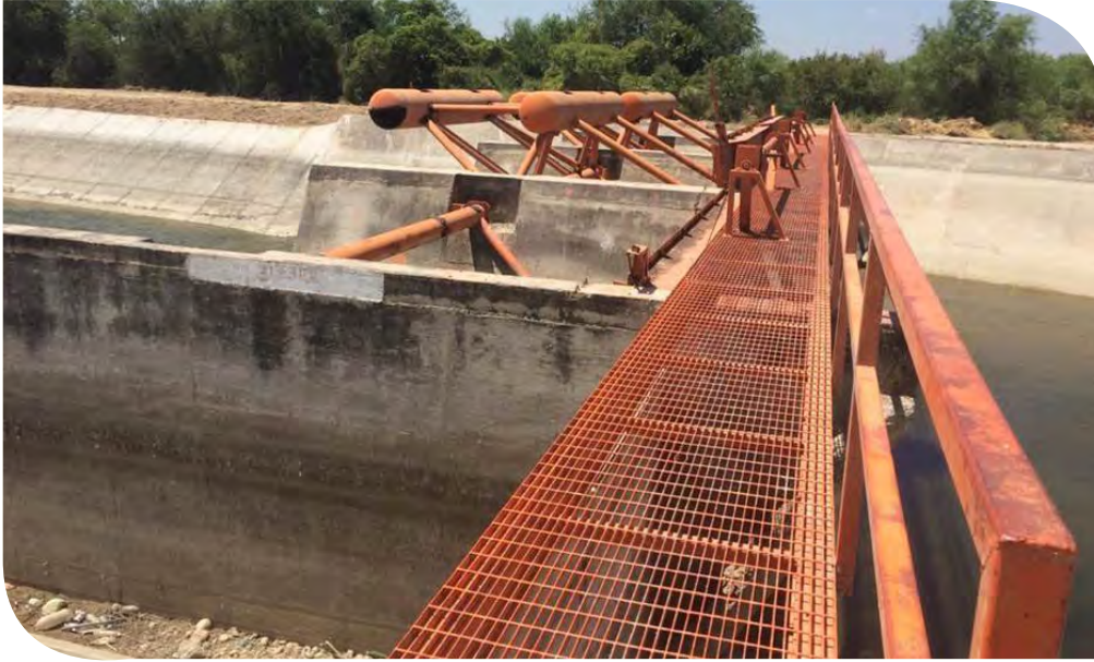
Figura 7.33. Compuerta AMIL convertida en compuerta aligerada. Fotografía: Lorenzo Armando Silva Escobedo.
