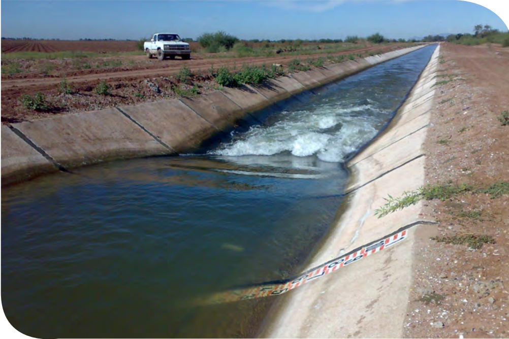
Figura 6.14. Aforador de garganta larga funcionando en un canal del DR041 Río Yaqui, Sonora
